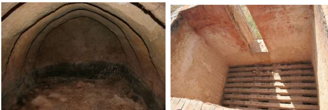
Figura 1. Cámara de combustión en la tejera de Lorenzo Gómez, 2010 © Pilar Corrales y Domingo Camuñas
